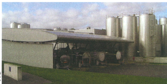
> La chaudière biomasse fournira 80 % de la vapeur nécessaire au site d'Herbignac.
